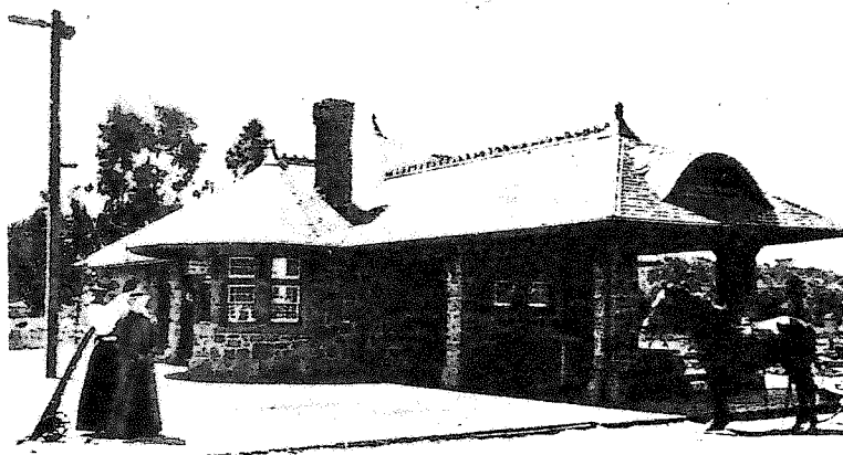
Depot of S. P. R. R., Kenwood, Cal.
